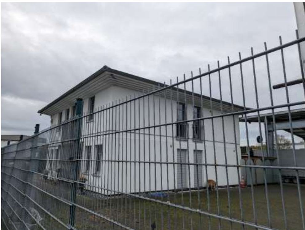
Wohn- und Bürogebäude, Nordwestansicht
