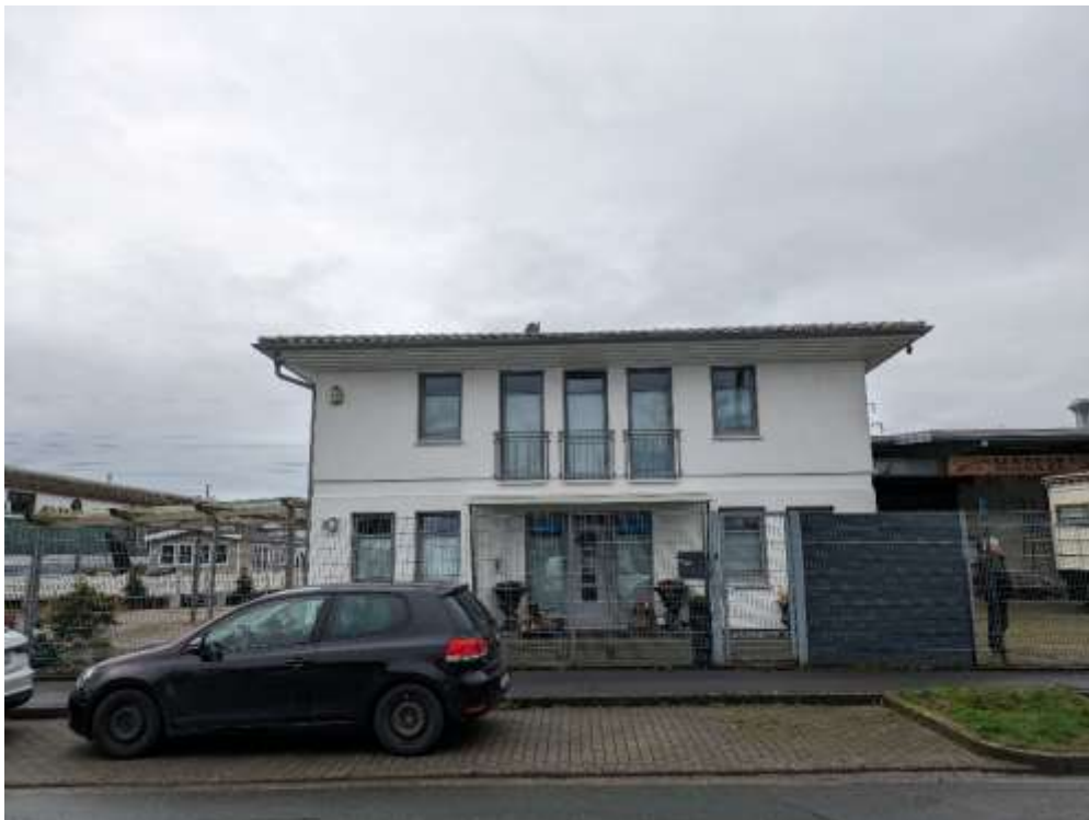
Wohn- und Bürogebäude, Nordostansicht
