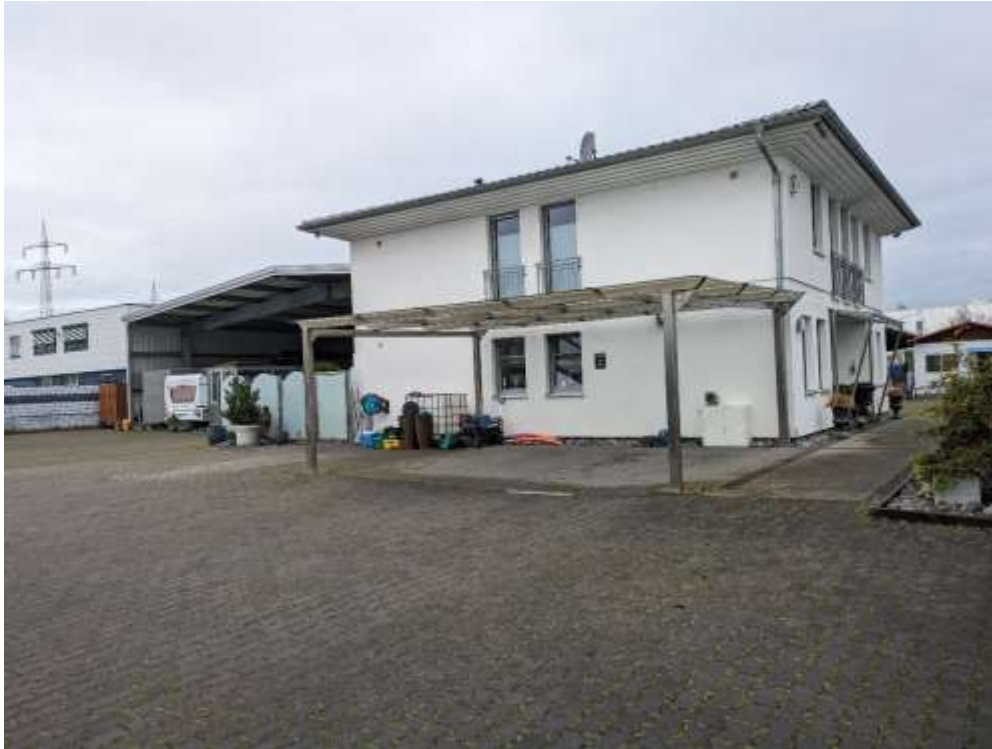
Wohn- und Bürogebäude, Südostansicht
