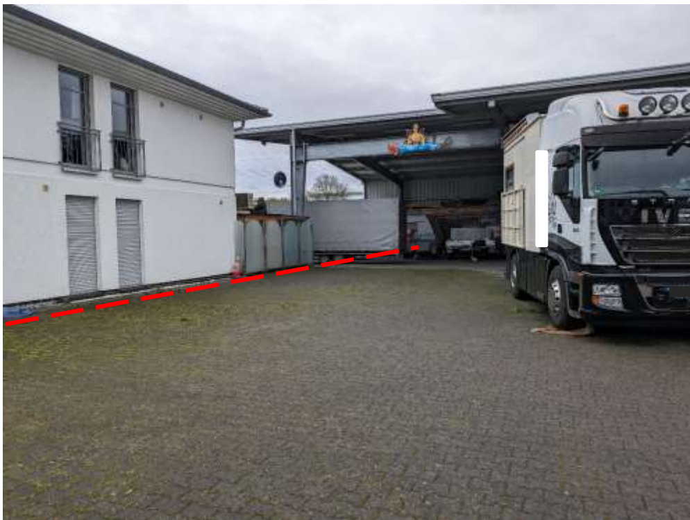
auf das Bewertungsgrundstück ragende Überdachung von Flurstück 3479 (Baulastblatt 13180)
