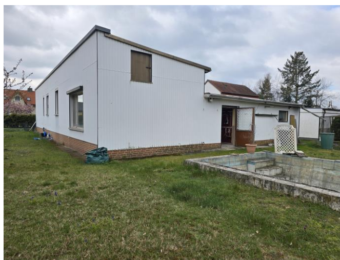
rechte Hausseite / Hausrückseite mit Anbau
