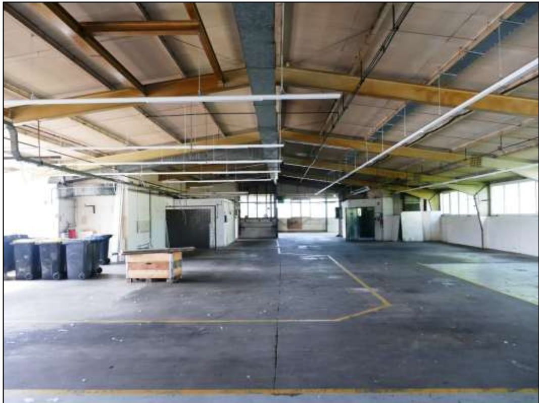
allgemeiner Zustand Halle 1
