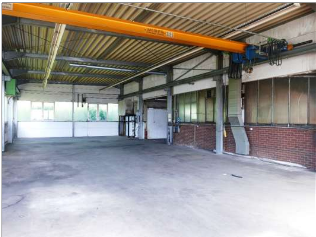
allgemeiner Zustand Halle 2
