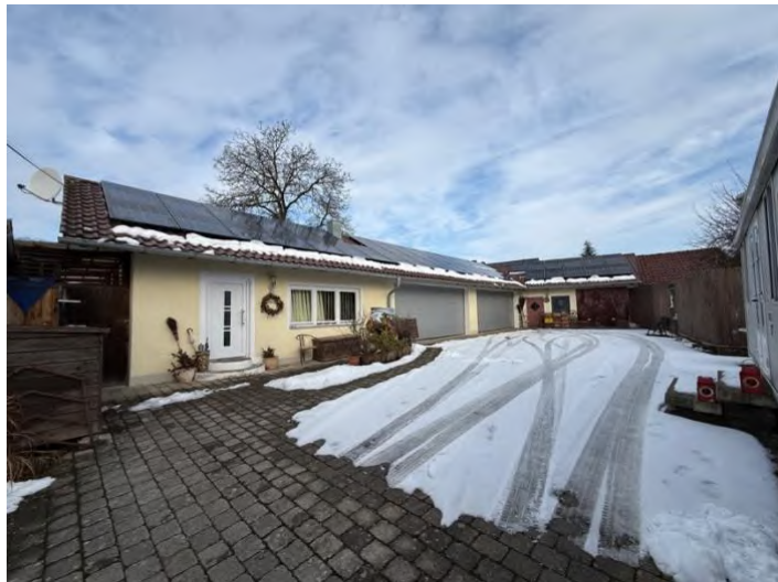
Südostansicht Garagen-/Nebengebäude mit Büroanbau
