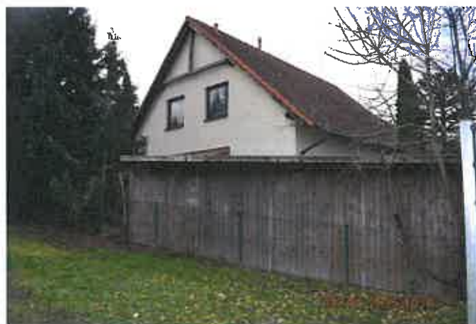
giebelseitige Ansicht mit Carport
