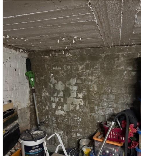
Bild 6: durchfeuchtete Kellerwand
